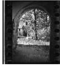
SAS.I, Blick durch den Torbogen auf den Uhrenturm, DE000322, BSV
