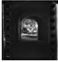
SAS.I, Blick durch den Torbogen, DE000321, BSV
