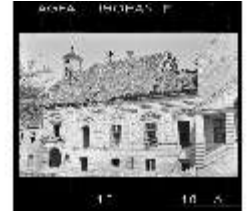
SAS.I, Kriegszerstörte Westseite, Nordteil, DE000346, BSV
