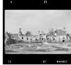
SAS.I, Kriegszerstörte Ostfassade, DE000331, BSV
