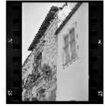
SAS.I, Fassade, Schrägansicht, DE000338, BSV
