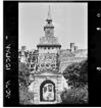
SAS.I, Kriegszerstörte Uhrenturm im Wiederaufbau, DE000343, BSV
