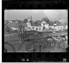
SAS.I, Kriegszerstörte Ostfassade, DE000327, BSV
