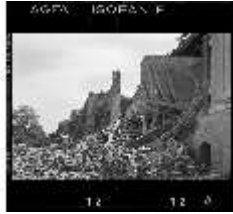
SAS.I, Kriegszerstört Ostseite (Detail), DE000348, BSV
