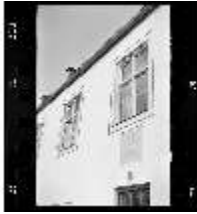
SAS.I, Fassade, Schrägansicht, DE000339, BSV
